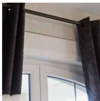
Volet monobloc Caisson apparent à l'intérieur
